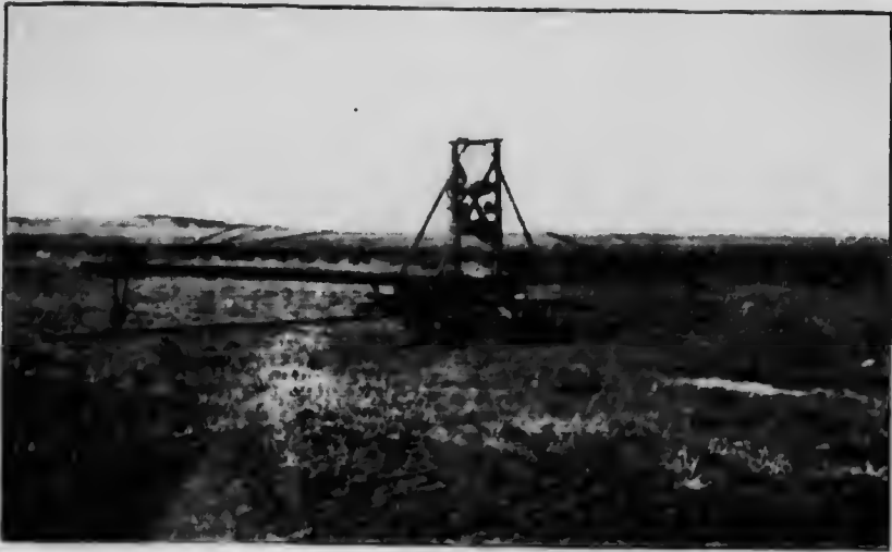
Appareil deavage et de déplacement des moules à Moselund Danemark.
