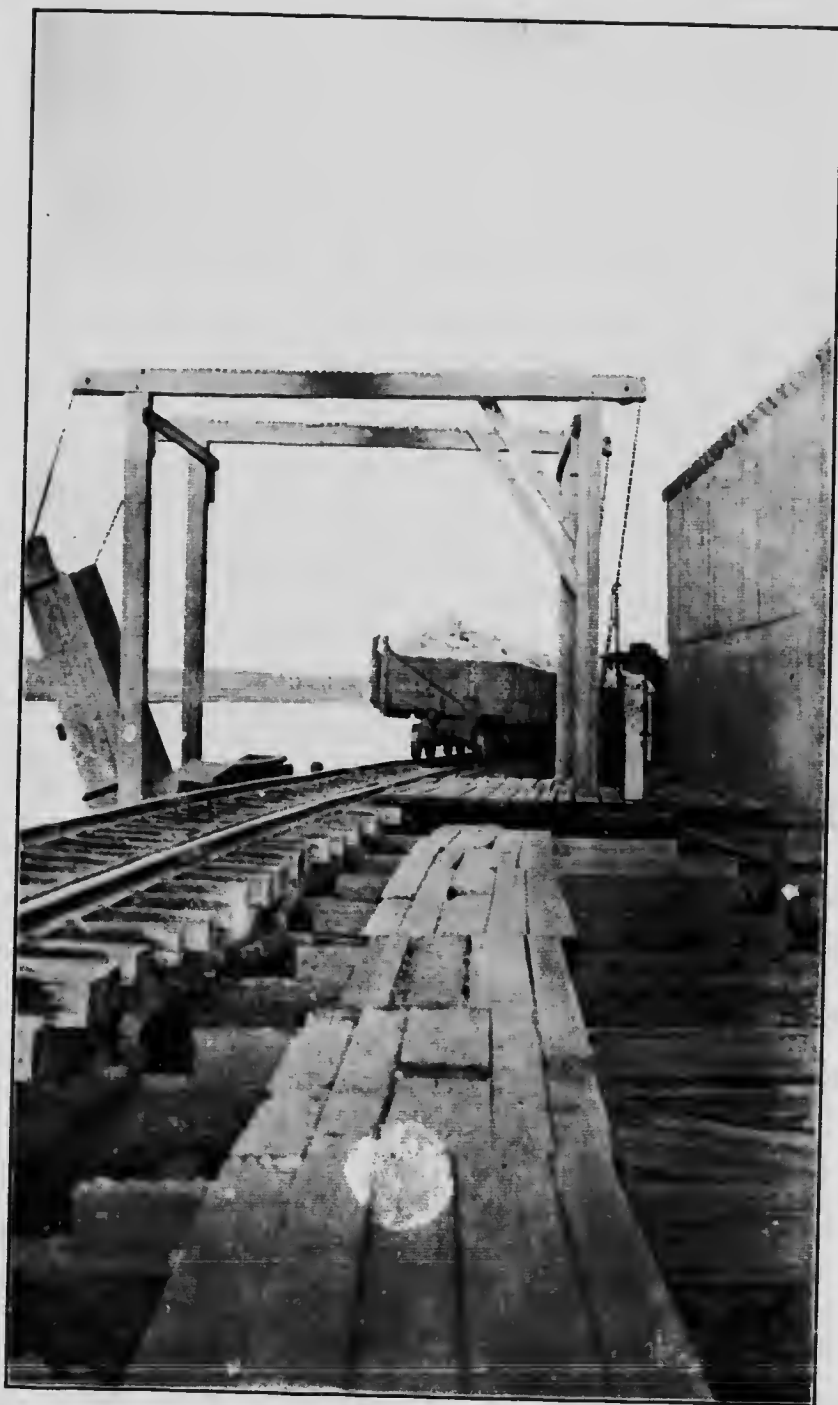
Le quai et l'appareil de chargement; Wentworth Gypsum Co.
