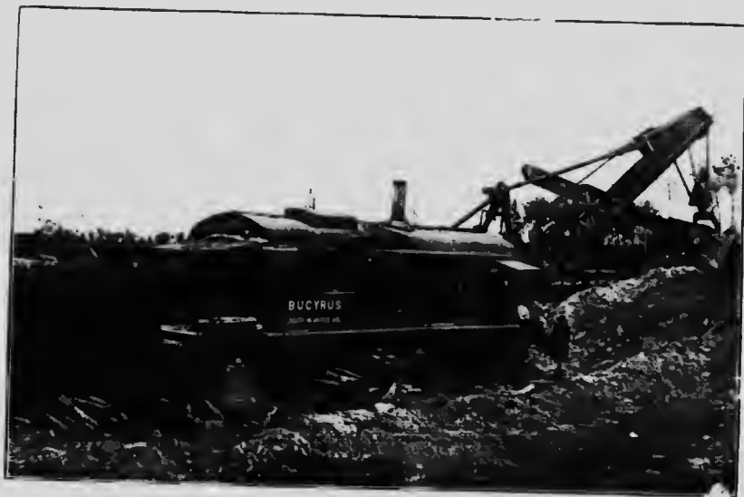
B. Pelle à vapeur chargeant le gypse dans les wagons: Manitoba Gypsum Co., Gypsumville, Man.
