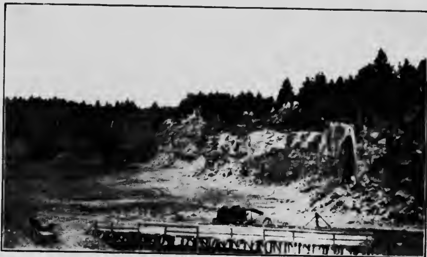
A. Carrière de la Wentworth Gypsum Co. Vue d'ensemble de la moitié occidentale, montrant une partie de la plateforme de chargement.
