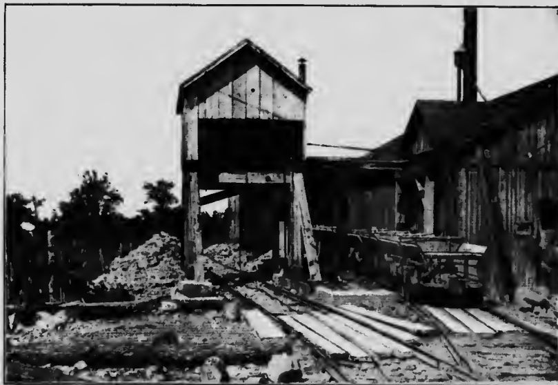
B. Treuil et wagonnets de la Crown Gypsum Co., York, Ont.
