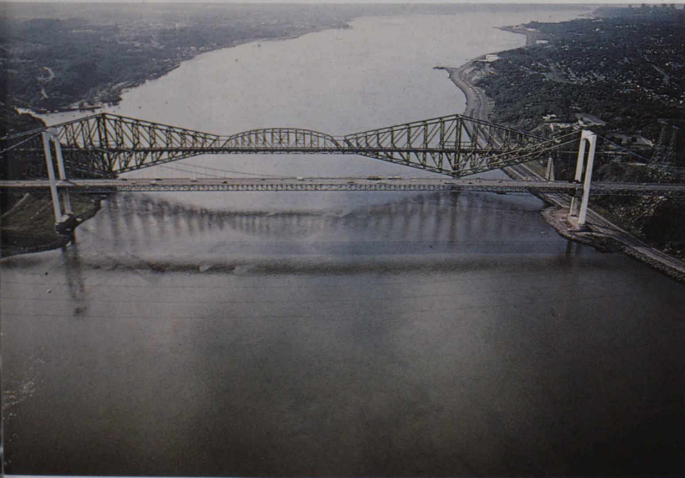
Il Ponte del Quebec sul San Lorenzo
