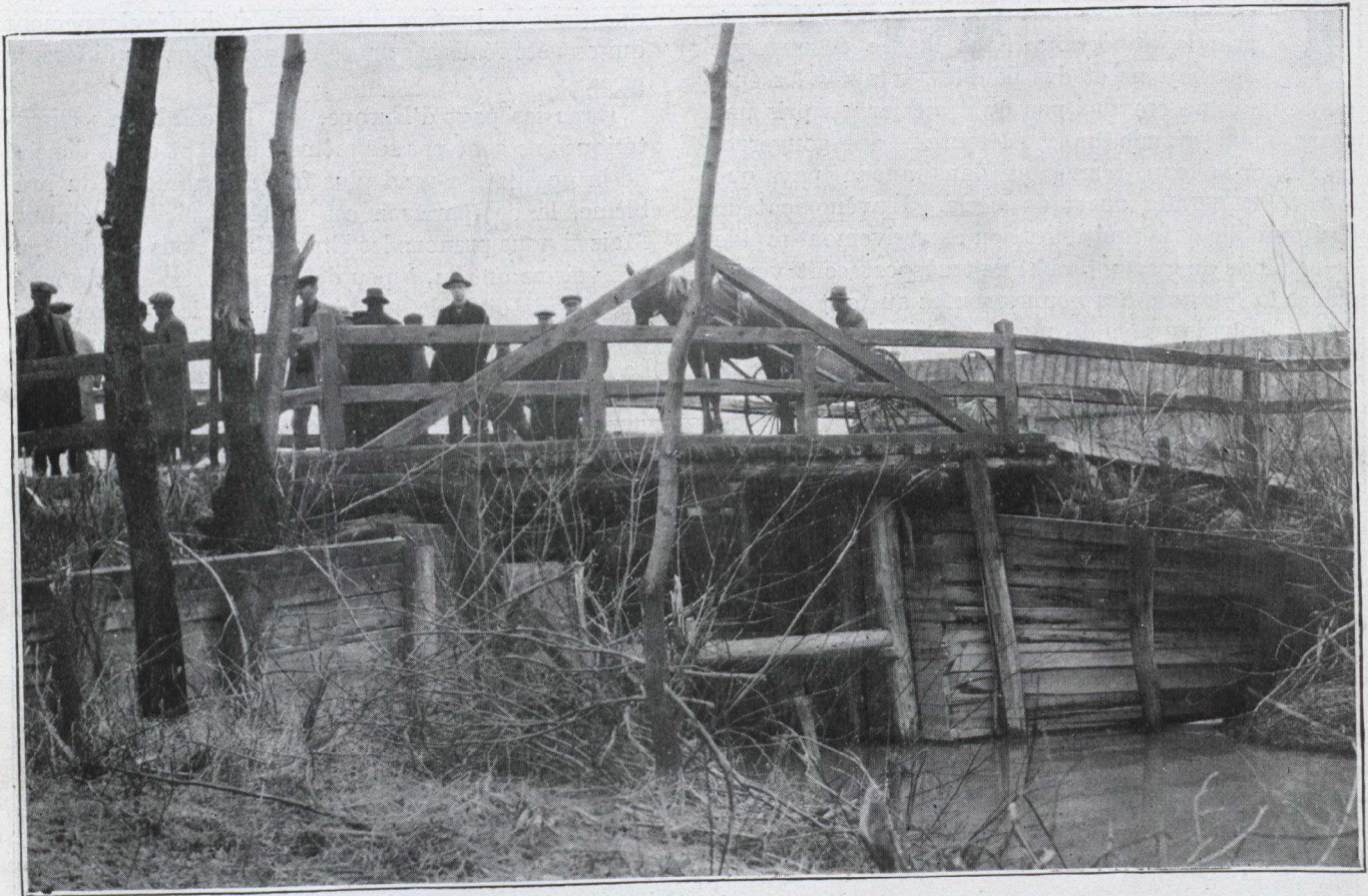
Pont Guinard, sur la rivière Larmière, à Maskinongé, comté de Maskinongé. Pont en béton armé d'une travée libre de 25 pieds et d'une largeur claire de voie charretière de 20 pieds. Ce pont a été construit en 1920. Voir ci-contre la photographie du vieux pont de bois.
