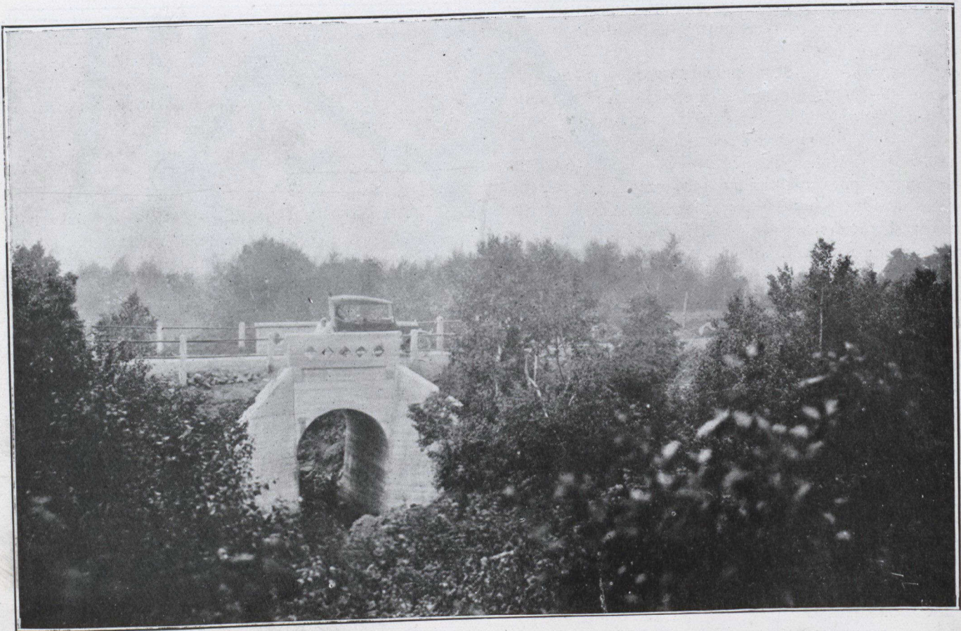
Pont dit du Trou St-Patrice, à St-Laurent, I.-O., comté de Montmorency. Pont en béton armé, ayant une ouverture de 10 pieds et une largeur de voie charretière de 16 pieds. Construit en 1920.
