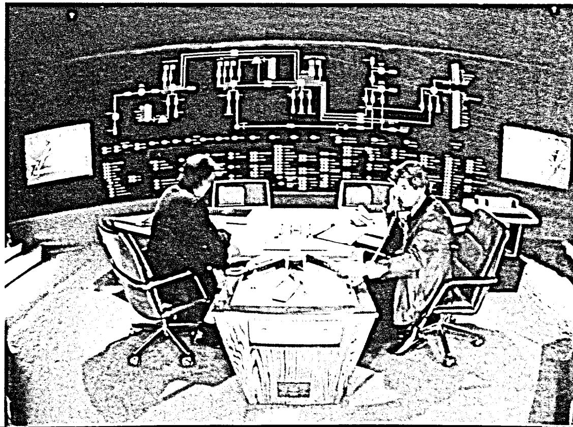
Le centre de contrôle du réseau surveille le trafic des télécommunications pour réduire au minimum l'encombrement des circuits internationaux.
