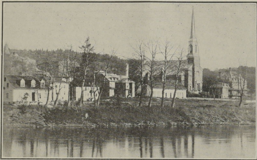
SAINT JOSEPH DE LA BEUCE.— Sur les rives de la "Chaudière, place de l'église, après les inondations "annuelles."
