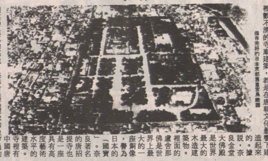
奈良和京都，都是日本古建築寶庫之地。奈良是模仿中國古建築縮小四分之一而建的。那裡的寺廟建築，都是仿照中國唐代文化而建的。
