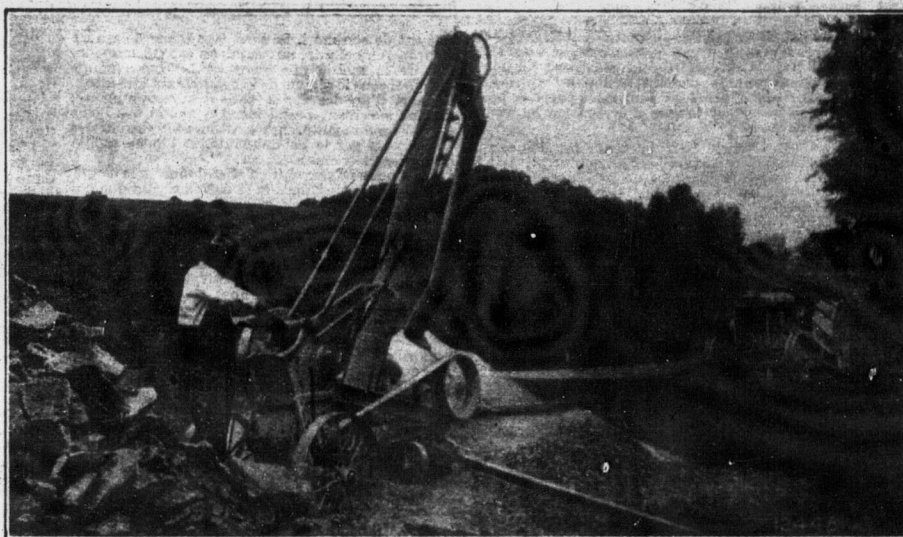
Petit broyeur de pierre à chaux en opération sur une terre.
