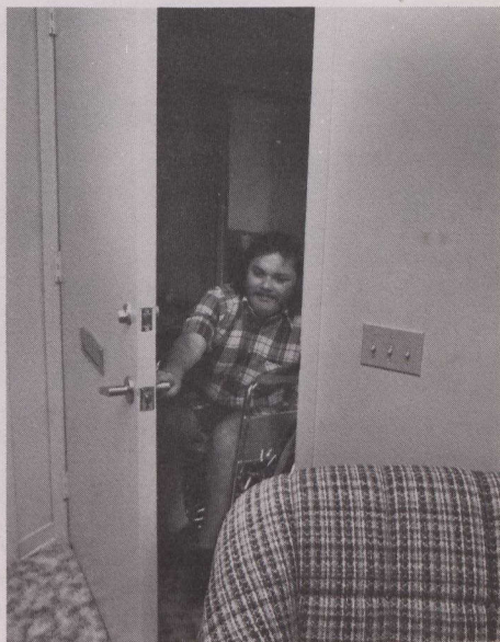
Sur la porte d'entrée, la serrure et la poignée plus basses que la normale ne posent aucun problème pour une personne assise dans un fauteuil roulant.
