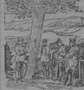
Reparierte Telephon- Leitung.
