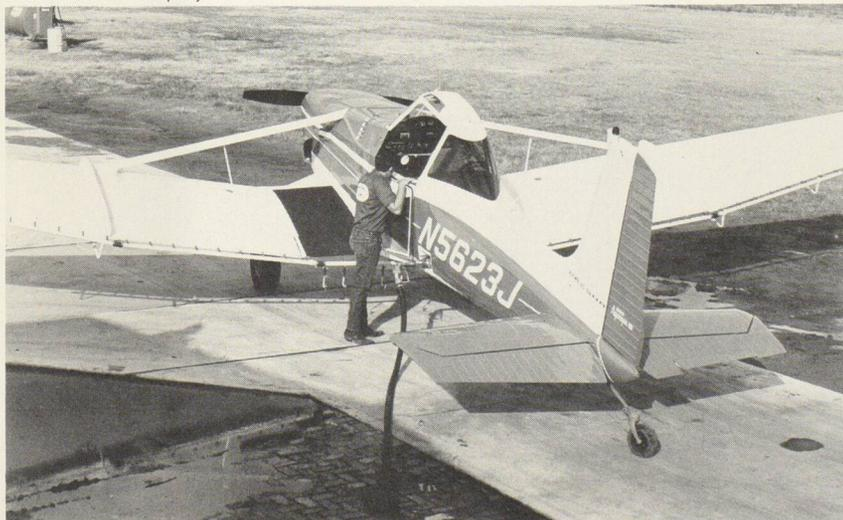
Remplissage du réservoir de produits antiparasitaires d'un avion Cessna "Agwagon B". A droite, vue des tuyères de pulvérisation montées au bord de fuite des ailes.
