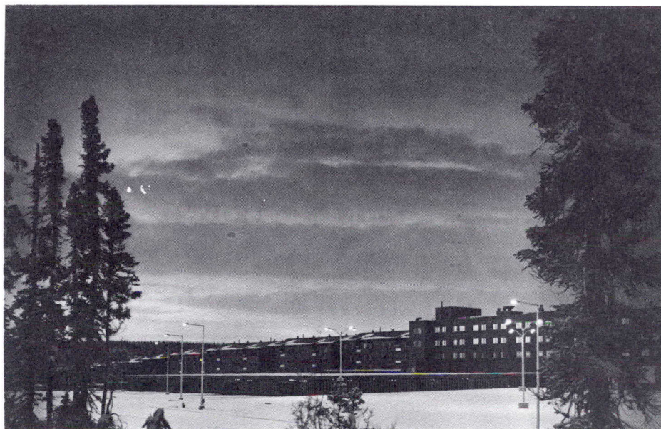
Parte del "Parabrisas". El edificio tiene casi kilómetro y medio de largo.
