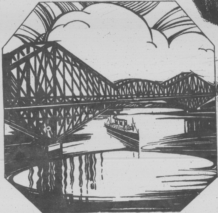
Le plus grand pont cantilever du monde Le pont de Québec 1917
