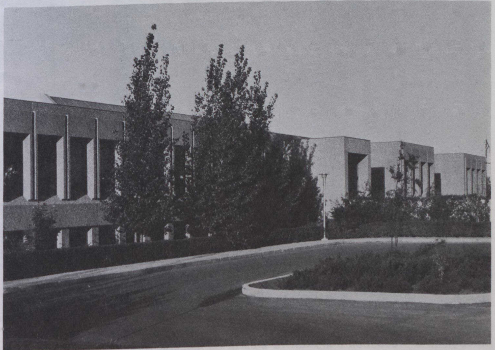
Vue extérieure de l'usine pilote PHA, ouverte en 1977 à Saskatoon (Saskatchewan).
