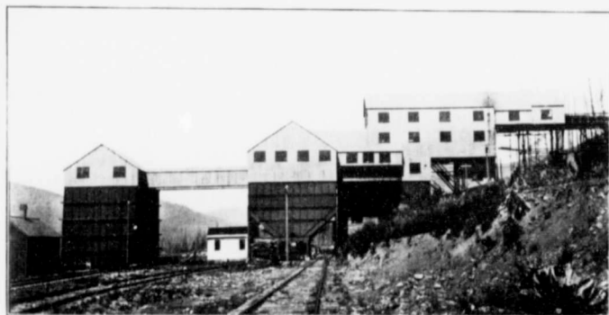
ATELIER DE CRIBLAGE EN ACIER, HOSMER MINES, LTD., HOSMER, C.B.
