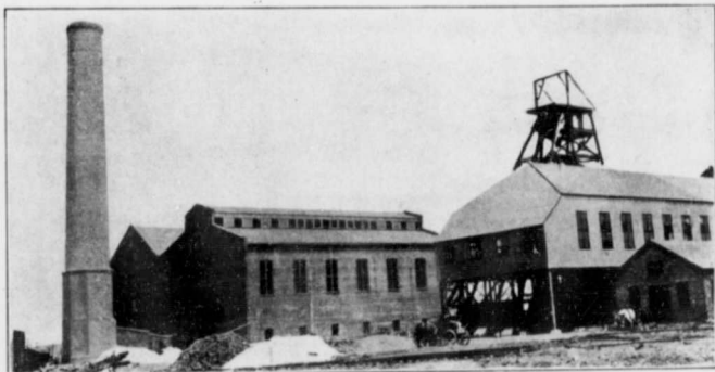
USINE GÉNÉRATRICE ET ATELIER DE CRIBLAGE, PUIIS ALLAN, ACADIA COAL CO.
