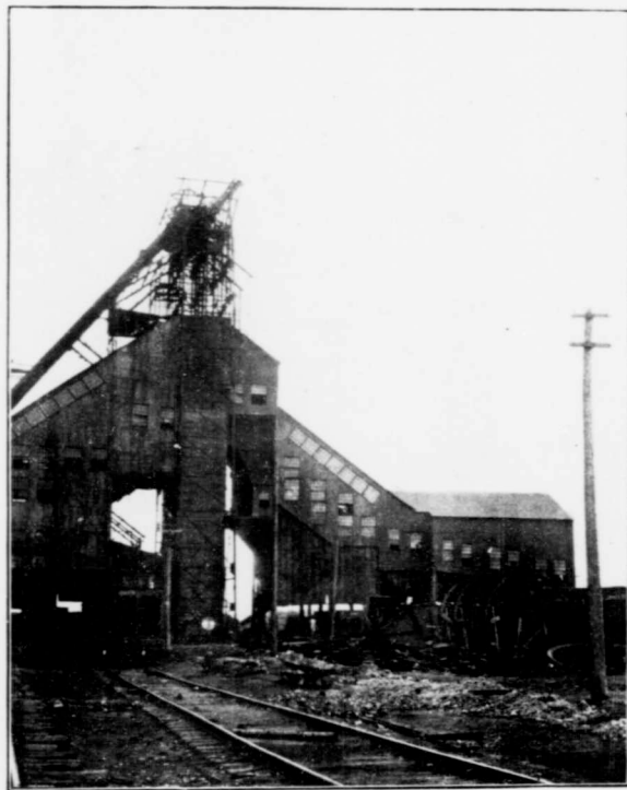
ATELIER DE CRIBLAGE EN ACIER, HOULLÈRES NOS. 2 ET 9, DOMINION COAL CO., NEW ABERDEEN, N.E.
