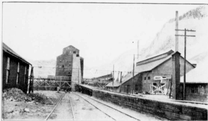
USINE GÉNÉRATRICE ET ATELIER DE CRIBLAGE, BANKHEAD MINES, LTD.
