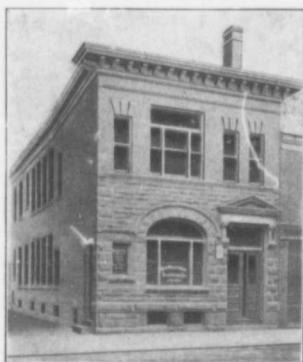
N. B. TELEPHONE CO.'S OFFICE, FREDERICTON, N. B.
