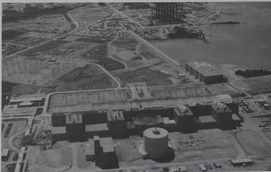
Overzicht nuclaire installaties Briece A.
