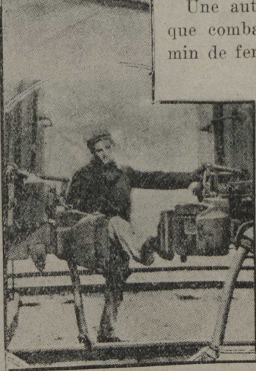
D'une adroite manoeuvre du pied on peut décrocher certains appareils sans se glisser entre les wagons.
