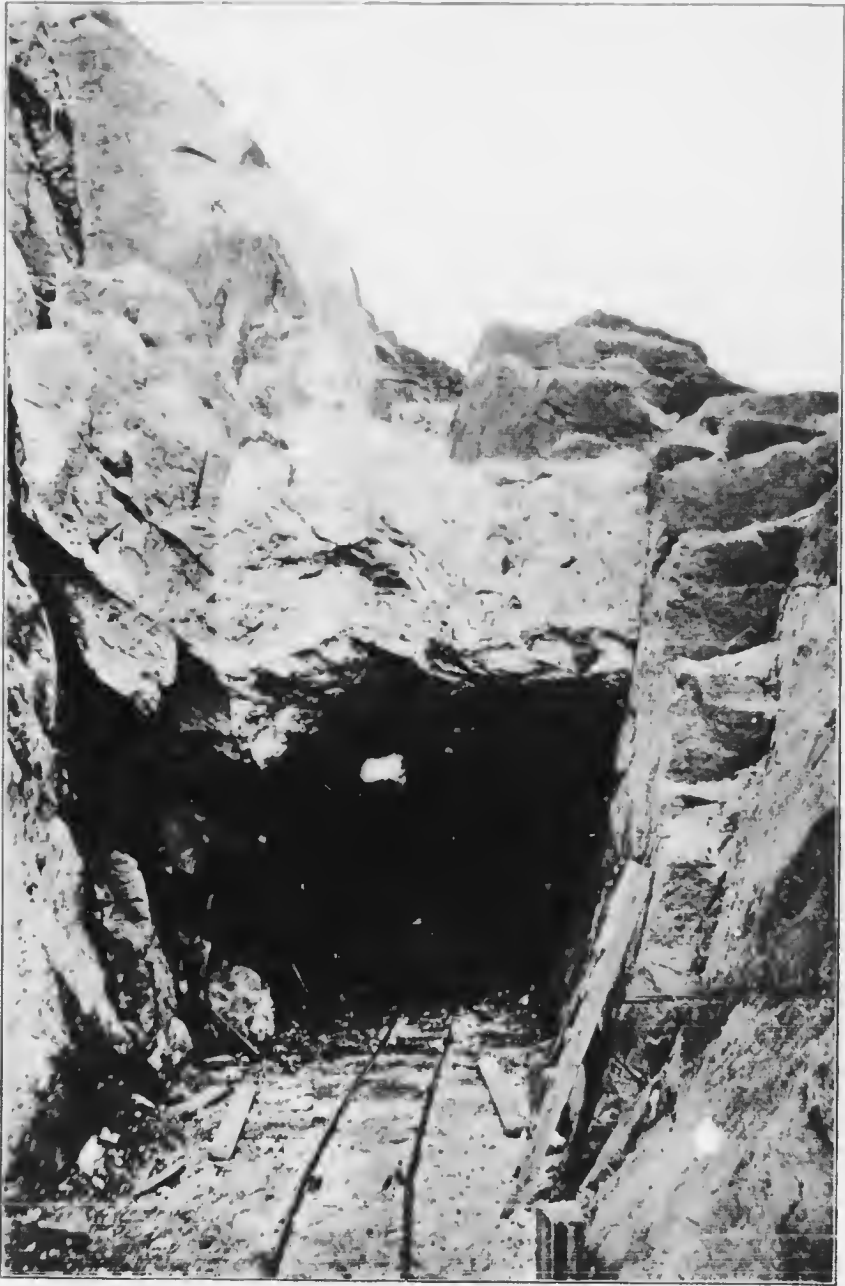
Méthode d'exploitation d'un dyke de feldspath, à Mosken, îles Lofoden, Norvège.
