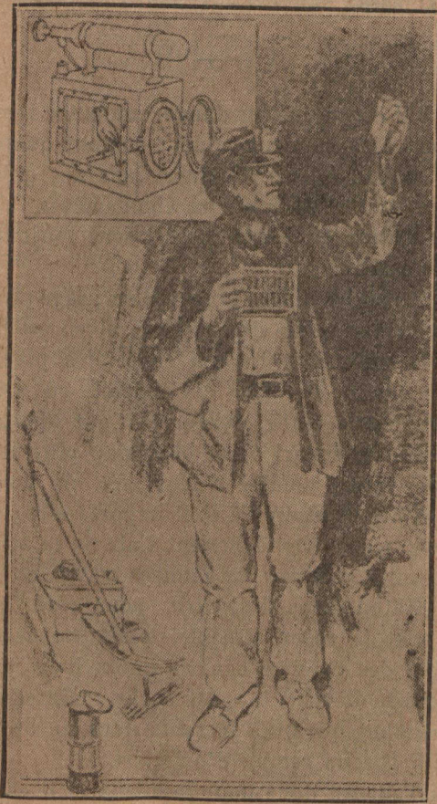
On fait revivre les canaris asphyxiés au moyen de l'appareil figuré en haut de notre gravure.
