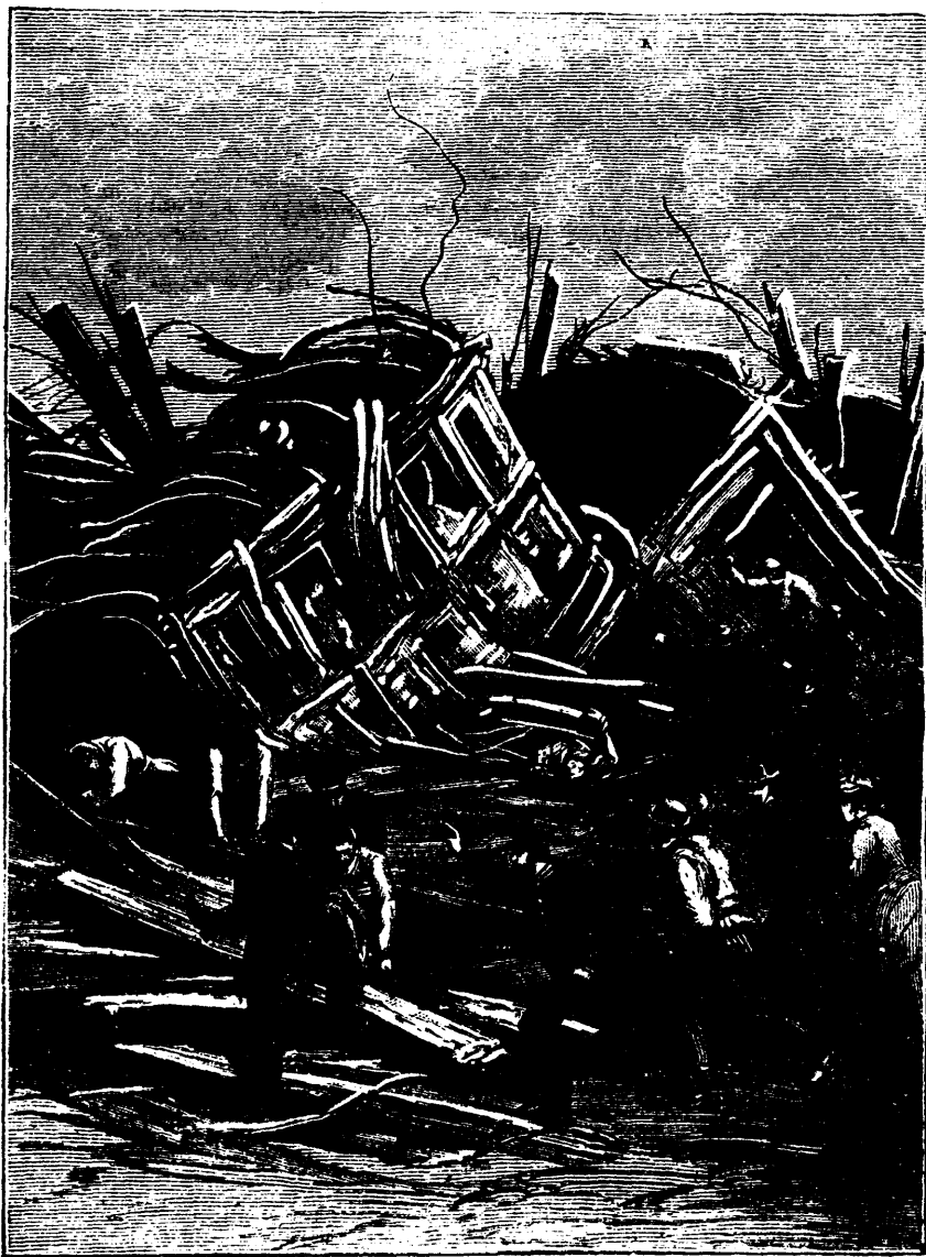
Trois wagons étaient complètement démolis.—(Voir page 270 col. s.)
