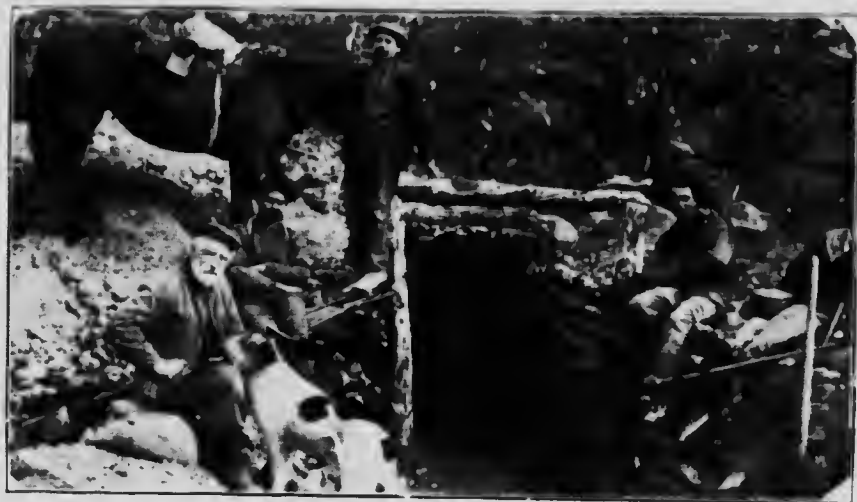
Entrée du tunnel, chemin maier Olive
