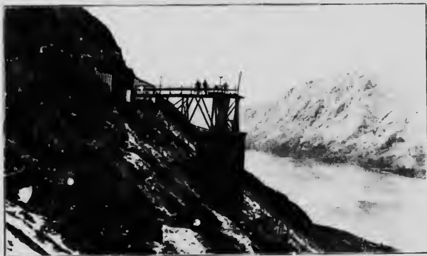
Voie à l'entrée principale, descente et nid de minéral, mine Venus. Quand la mine fonctionne le minéral est apporté de ce nid par tramway de va et vient aérien à l'atelier de préparation qui est situé sur la rive de Windy Arm à 1100 pieds à peu près en aval.
