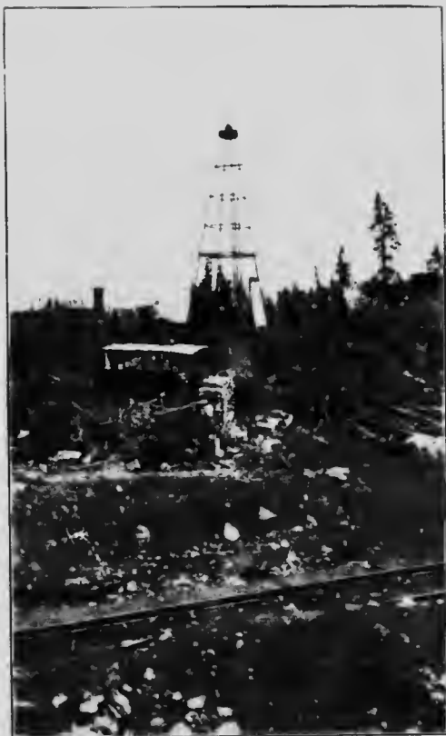
Perforatrice à balles fonctionnant sur le prospect de cuivre Best Chance, district de Whitehorse, T. Y.
