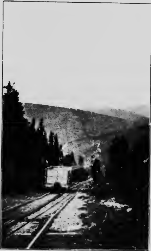
Wagonnet à minéral actionné par va-et-vient. Mine Lone Star.
