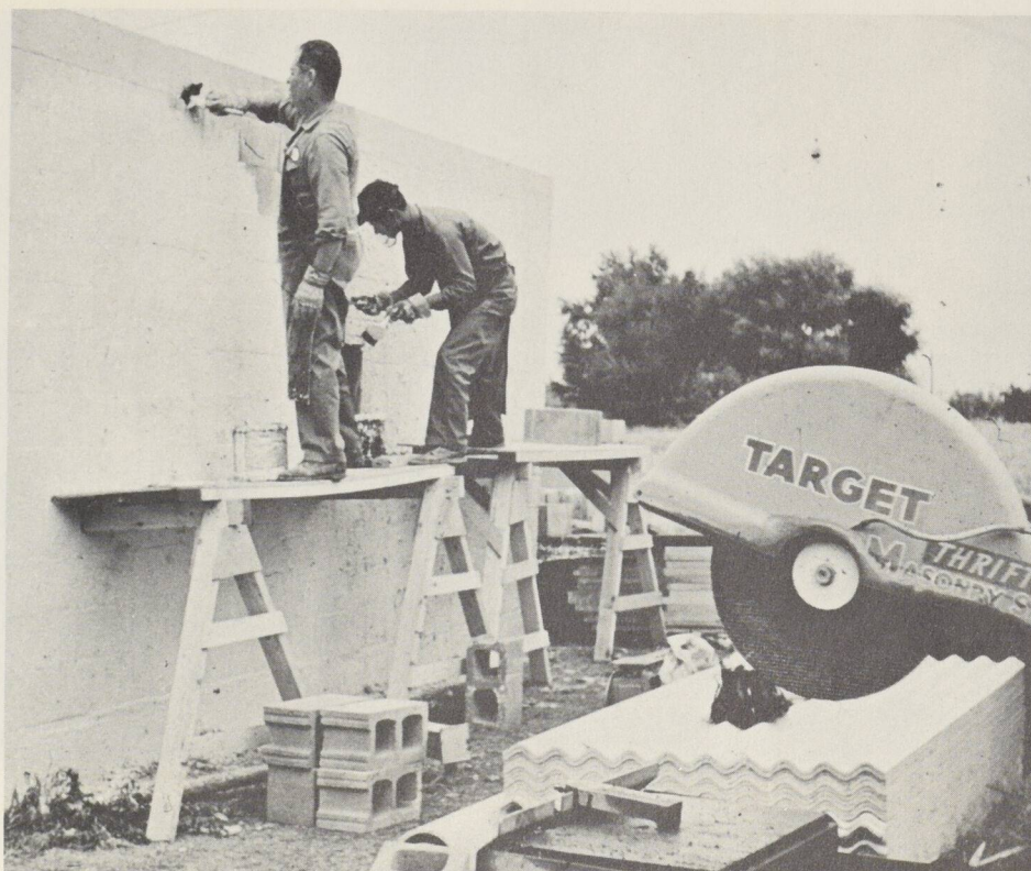
Maison expérimentale du Southwest Research Institute à San Antonio, au Texas. Une colle liquide à base de soufre, plus solide que le mortier, sert à assembler les parpaings. Elle se solidifie en se refroidissant et sa résistance atteint le maximum en cinq minutes.
