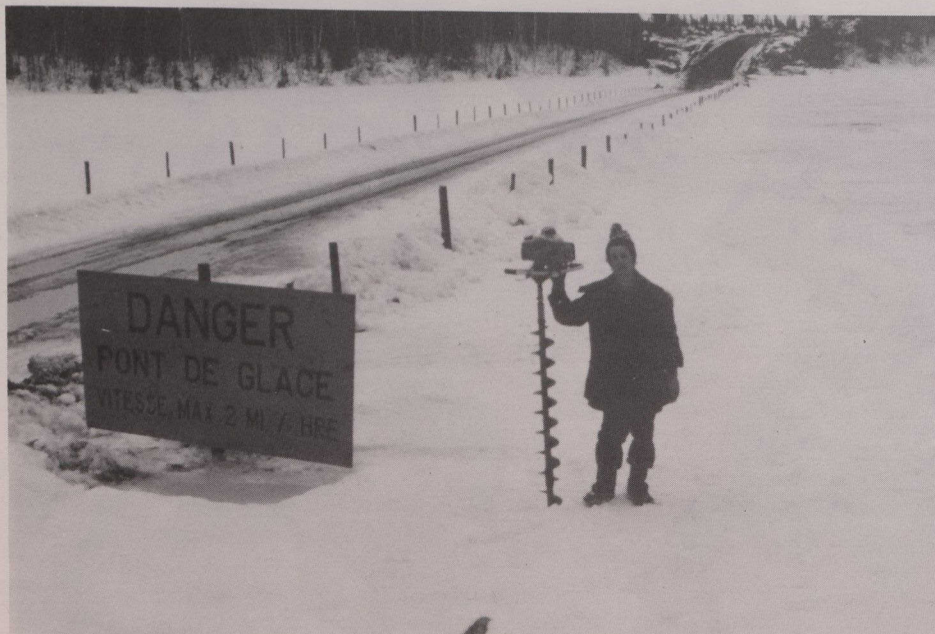
Construction d'un pont de glace conçu par Bernard Michel sur la rivière Bell à la baie de James.
