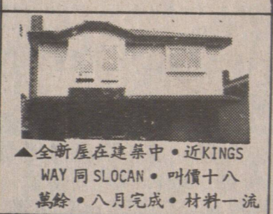
▲全新屋在建中。近KINGS
