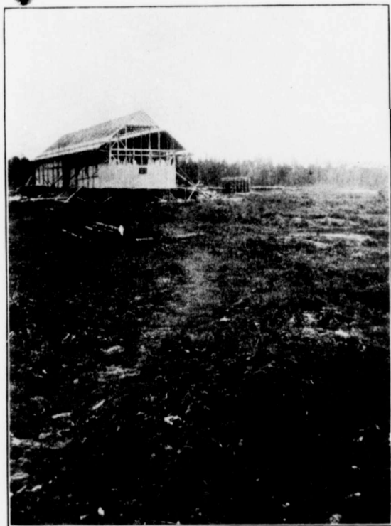
Construction de la grange-étable, en 1906
