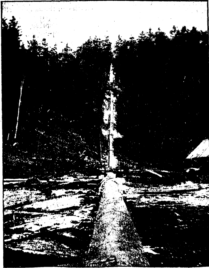
PIPE LINE, ANGLO-AMERICAN CO.
