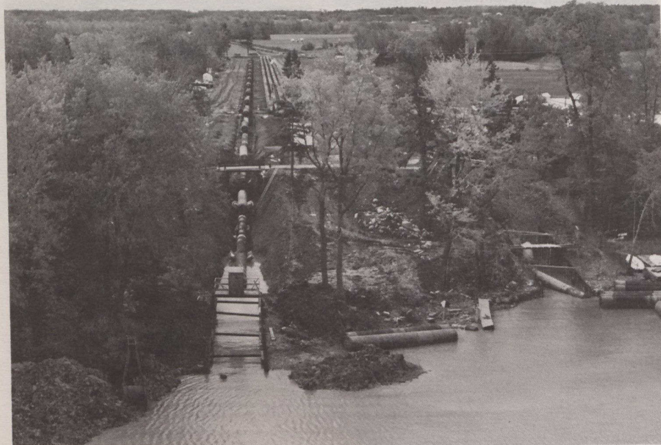
Monenco a participé à la construction du pipe-line de gaz naturel qui traverse le Québec et les Maritimes.
