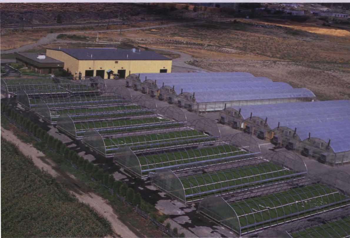
Vue aérienne des serres de Balco Canfor (Balco Canfor Reforestation Centre Ltd.)
