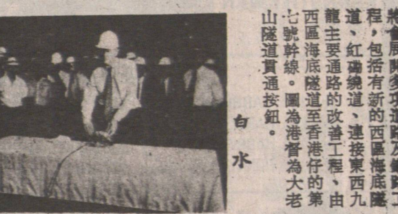
大老山隧道工程，預計於一九九一年中完工。
