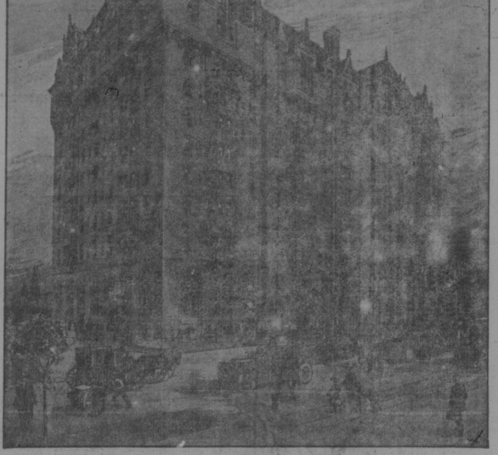
Das im Bau befindliche Hotel „L'Hotel“ der Grand Trunk Eisenbahn.
