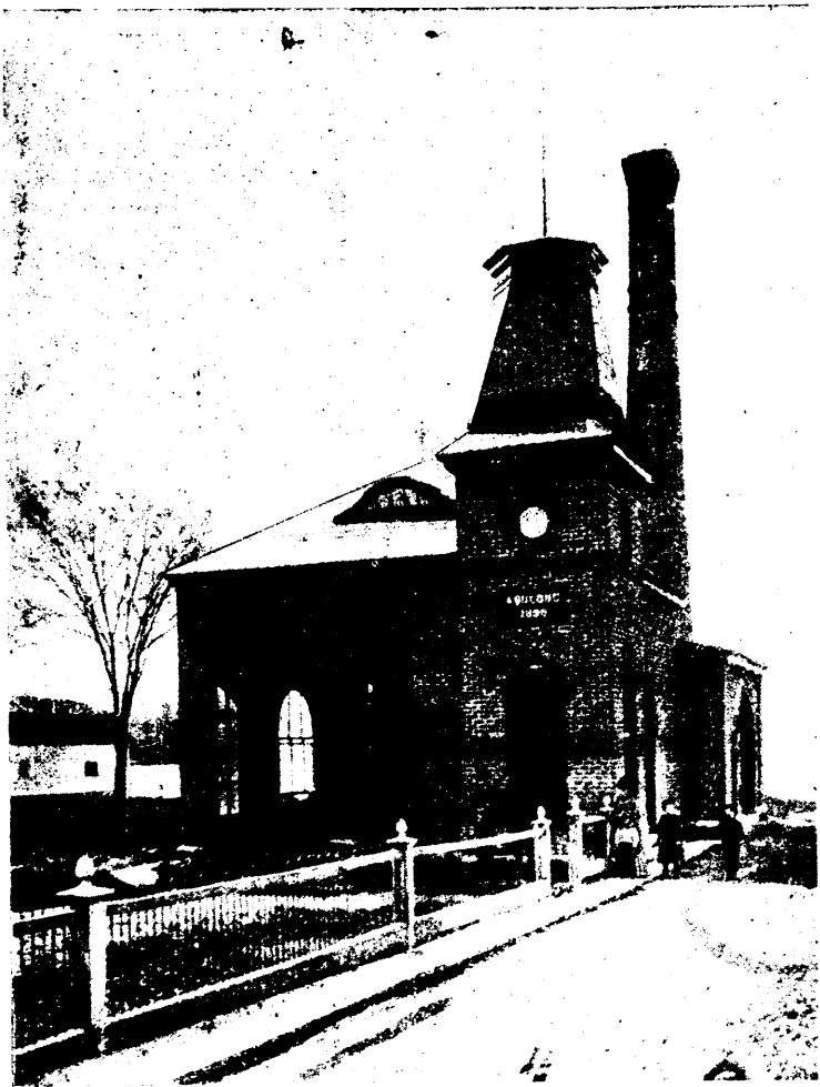
BATISSE DE L'AQUEDUC
