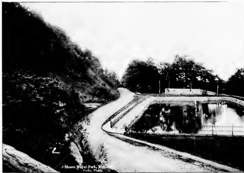
RÉSERVOIR À HAUTE PRESSION, PARC MONT-ROYAL.
