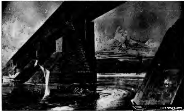
PONT VICTORIA, CHEMIN DE FER DU GRAND TRONC
