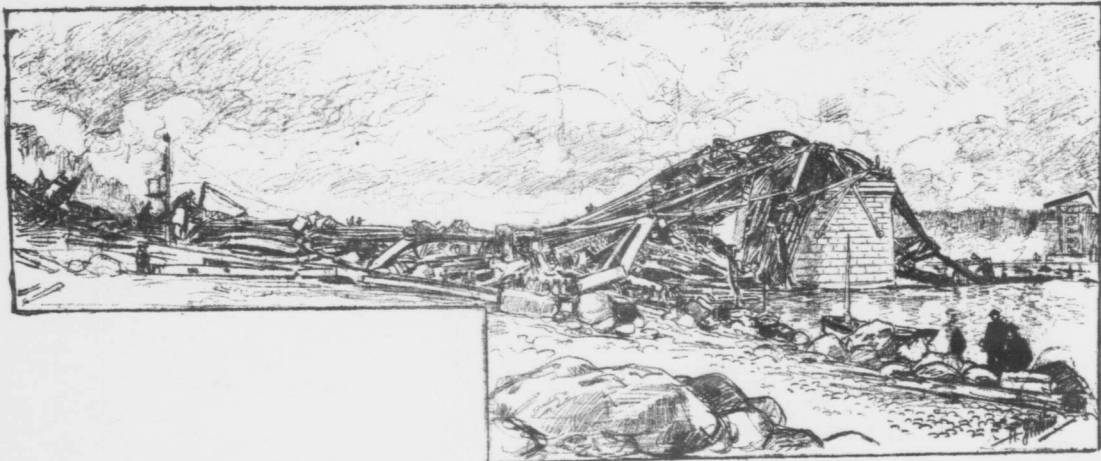
L'écroulement du Pont de Québec. — The collapse of the Quebec Bridge.
