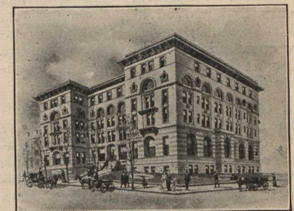
HOTEL VANCOUVER, VANCOUVER, B.C.
