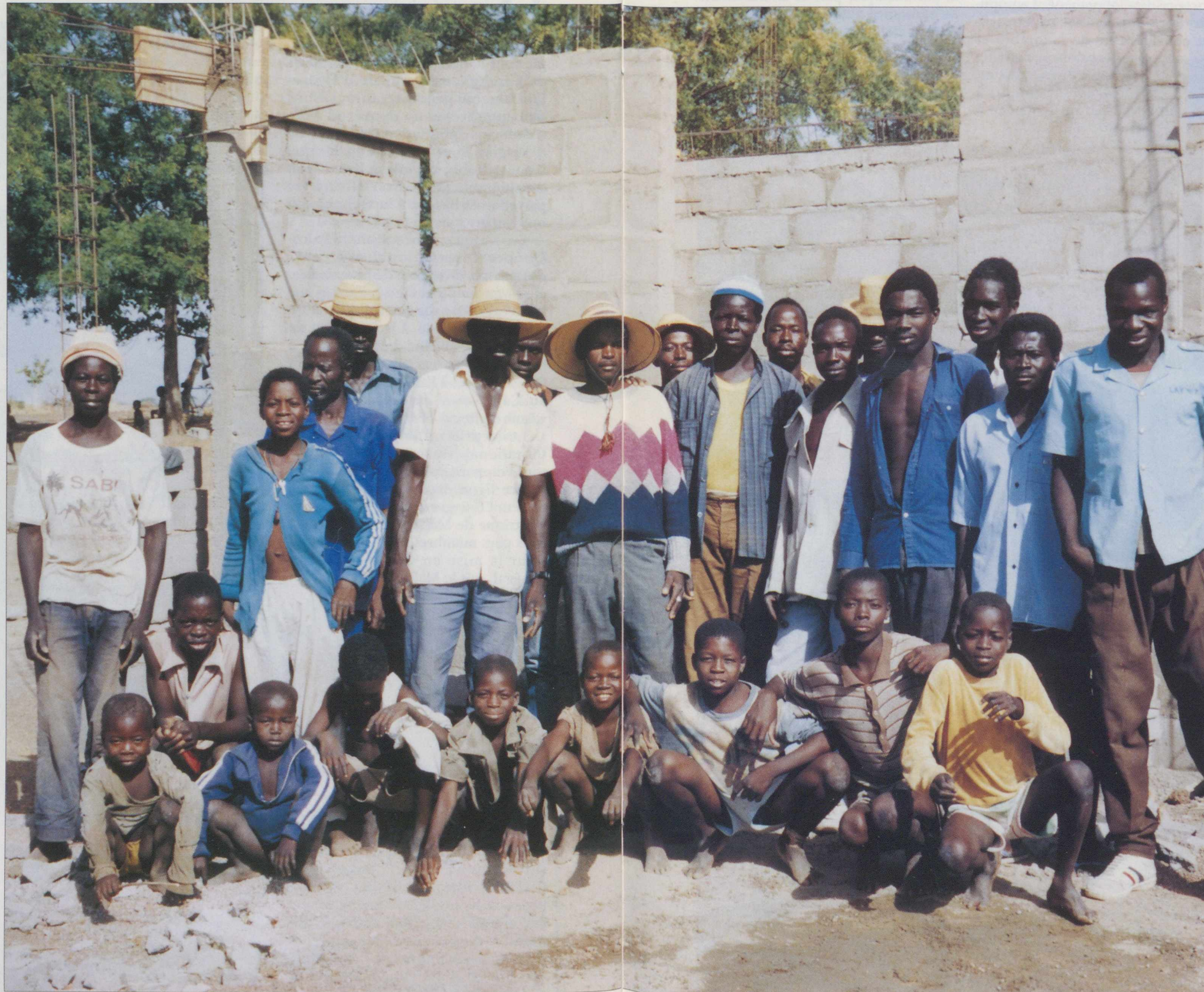
La population de Ziou participe avec entrain à la construction d'un bureau pour le responsable-vulgarisation.
