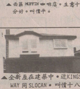
▲全新屋在建中·近KINGS WAY 同 SLOAN·叫價十八 萬餘·八月完成·材料一流
