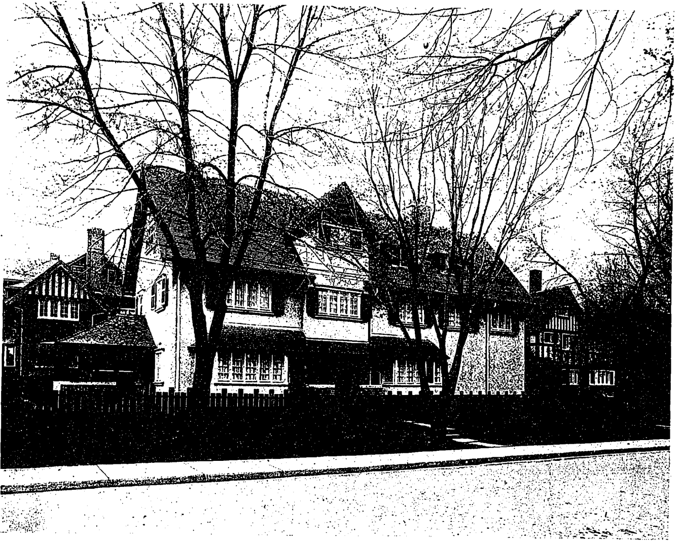
HOUSE NO. VI. TORONTO, ONTARIO.
