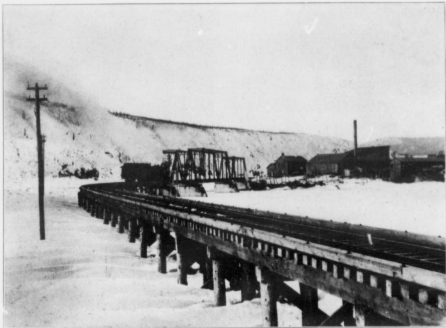
K. M. RAILROAD BRIDGE, KLONDYKE RIVER, DAWSON, Y. T.
