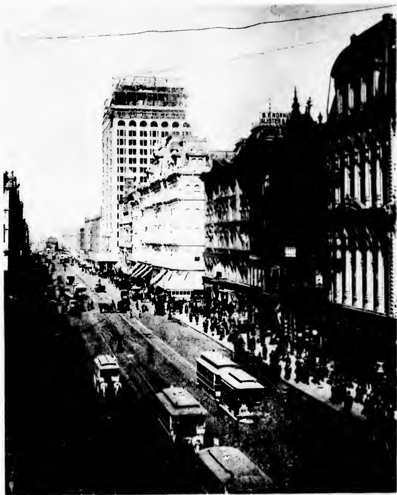
UNE RUE DE CHICAGO AVEC LE TEMPLE MAÇONNIQUE.
