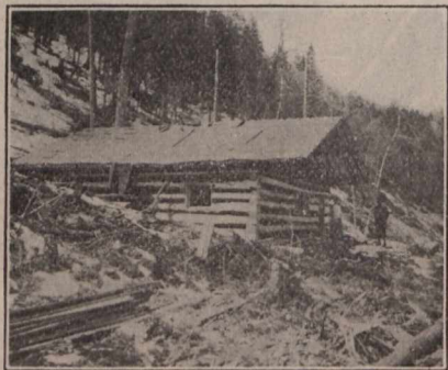
Résidence d'un sous-entrepreneur pendant la construction.
