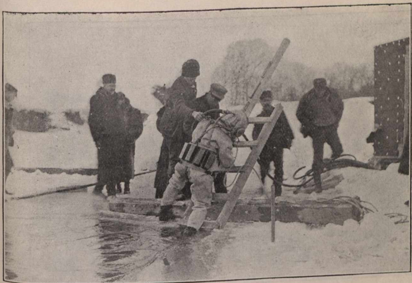
Scaphandrier employé à la construction des piliers dans la rivière St-Maurice.
