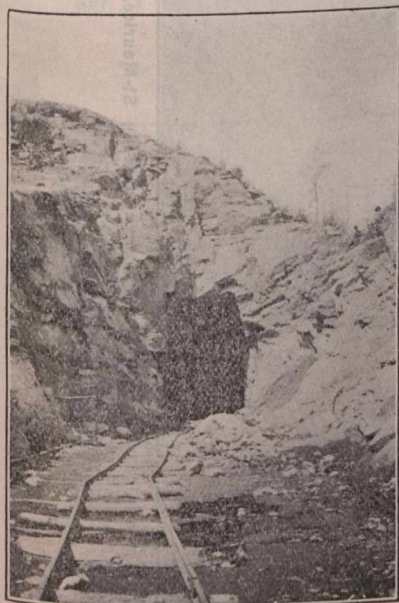
Tunnel près du "Fer à Cheval", La Tuque.
