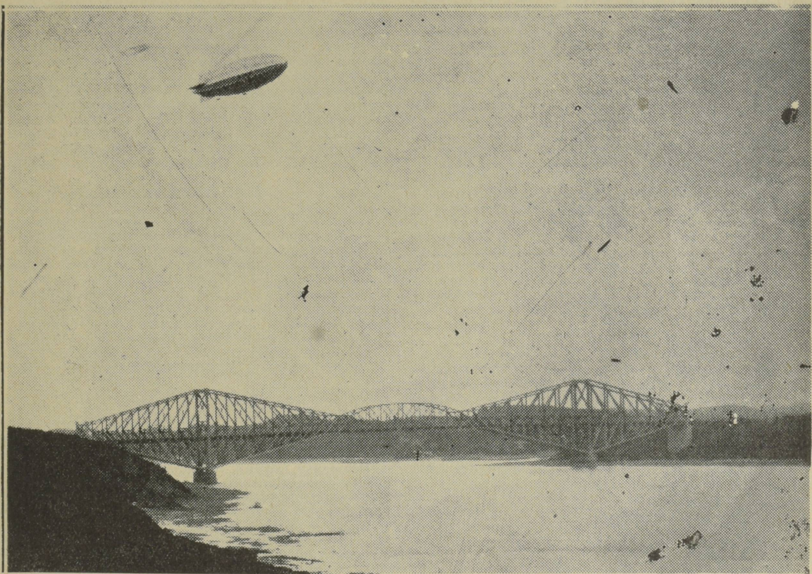
LE R-100 PASSANT AU-DESSUS DU PONT DE QUÉBEC
