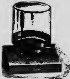
Fig. 72. — Nourrisseur Raynor simplifié.—En tournant le nourrisseur sur lui-même, on peut graduer la quantité de sirop donnée.
