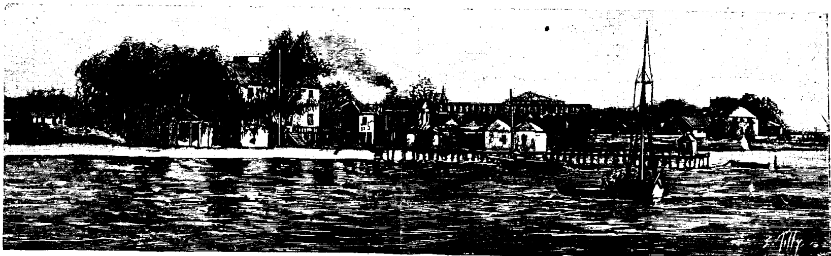
KEY-WEST (ETATS-UNIS).—Le lazaret et les nouvelles fortifications en cours de construction
