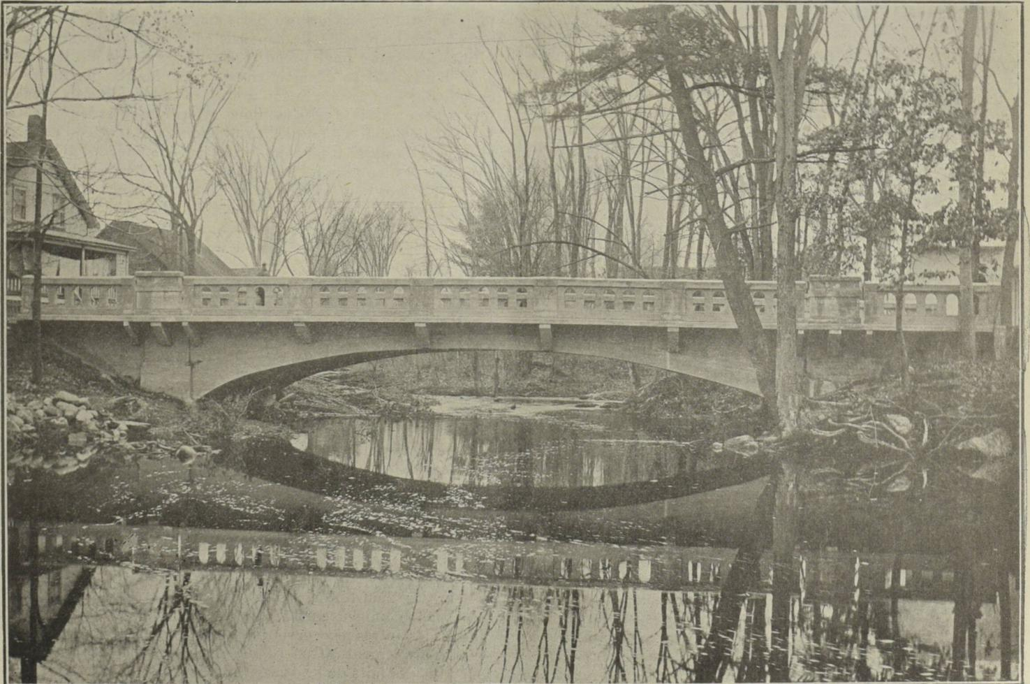
**Paysage et scène du terroir.**—Pont-arche sur le "Groats Creek", à Bedford, Missisquoi, en béton armé, ayant une longueur totale de 95' et une travée, au niveau des naissances de 60'. Il a une largeur de voie charretière de 20' et un trottoir de 4' 6" de chaque côté. Construit en 1923.
