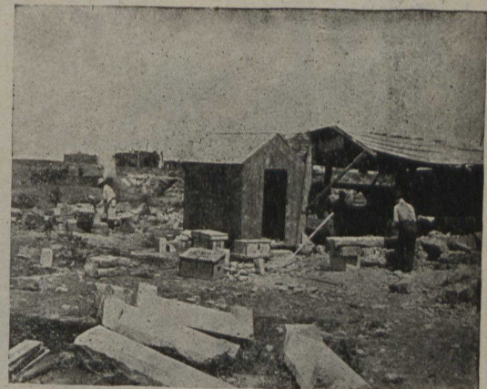
Des chantiers d'équarrissage sortent des blocs destinés à la construction.
