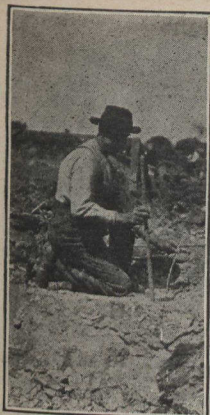
Le chargement d'une mine
