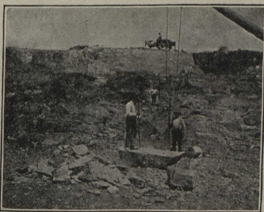
L'emploi des "chèvres" est nécessaire avec des pareils blocs
