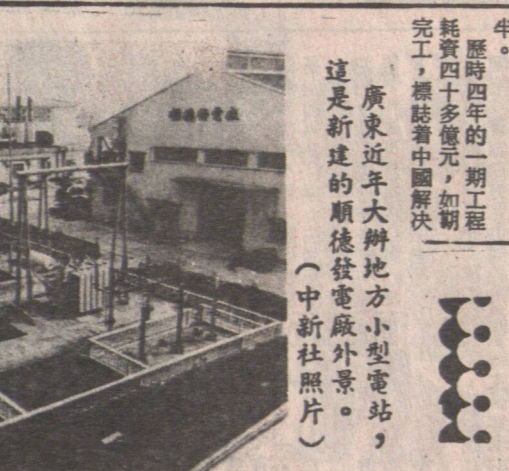
廣東近年大辦地方小型電站，這是新建的順德發電廠外景。
