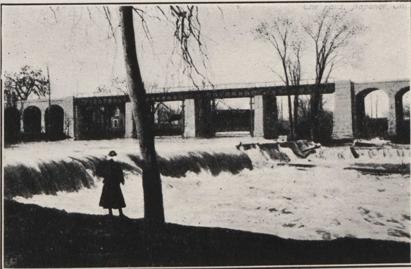
G. T. R. BRIDGE, NAPANEE. BUILT 1855.
