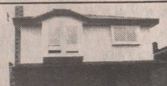
▲全新屋在建中。近 KINGS WAY 同 SLOCAN。叫價十八 萬餘。八月完成。材料一流
