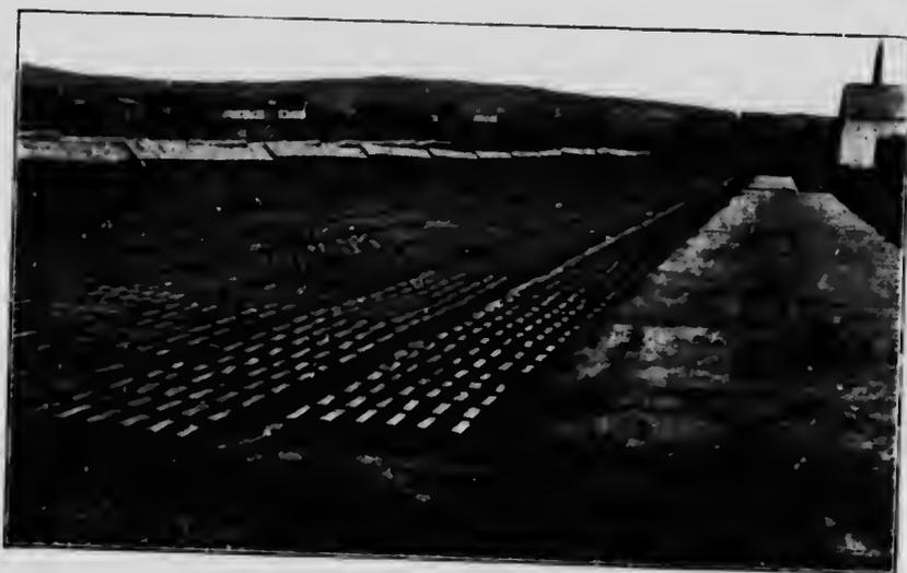
A. Aire pour le séchage des briques vertes, L'Islet.
