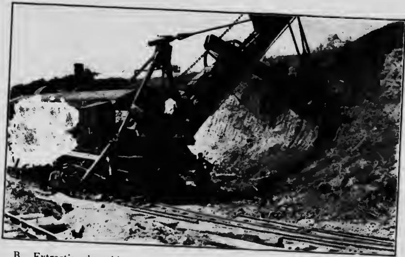
B. Extraction des schistes et de l'argile à la pelle a vapeur, à Delson Jonction.
