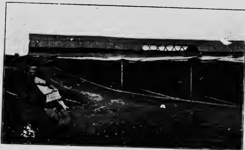
B. Séchage des briques sur planchettes et claies couvertes.
